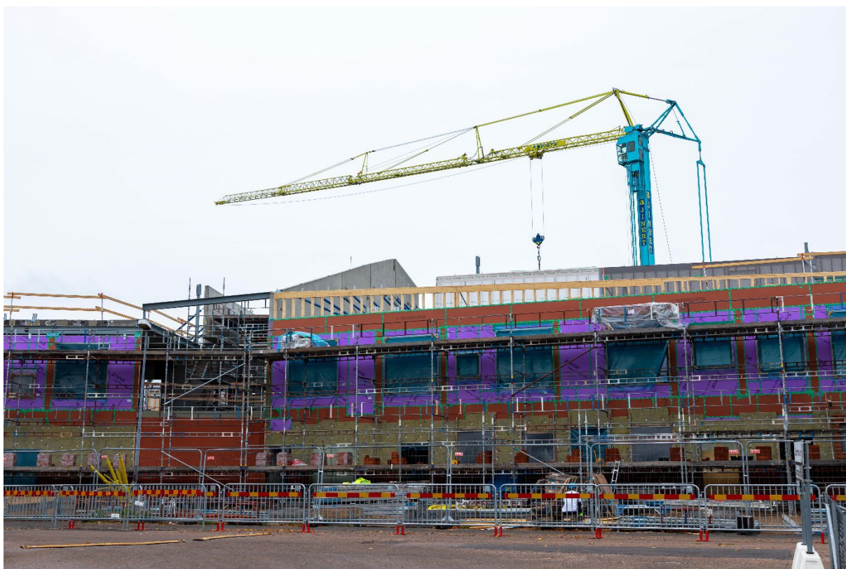
Nybyggnation av Bjäre skola.
